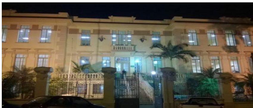
Foto 5 – A fachada do prédio que abrigou o estágio
