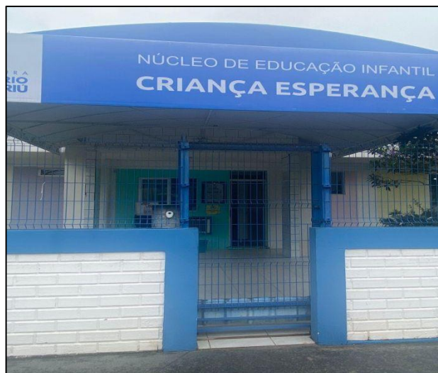
Fotografia 6 - Fachada atual do NEI
